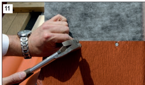
11 Der Kaminanschluss muss mit Dachpappstiften gegen Abrutschen gesichert werden. Wir empfehlen die Verwendung einer Abschlussleiste.
