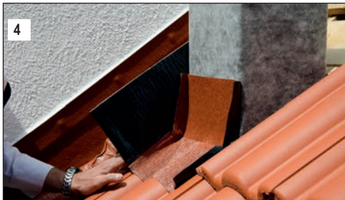
4 Seitenteil anlegen (15 cm über der wasser-führenden Ebene) und markieren.
