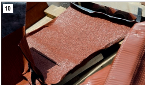
10 Kehlelement verlängern, anformen und Dacheindeckung vervollständigen.
