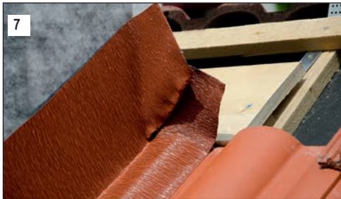
7 Seitenteil (15 cm über der wasserführenden Ebene) anlegen, markieren und anformen.
