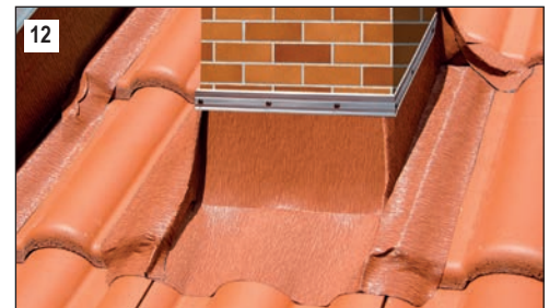
12 Fertig verlegte Kamineinfassung (im Bild CASA-Flash).
