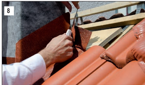
8 Kehlteil (15 cm über der wasserführenden Ebene) einlegen, markieren und abschneiden.
