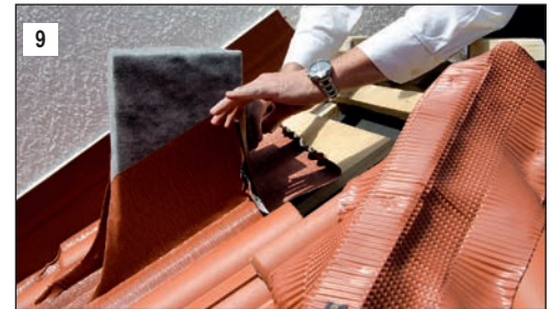
9 Kehlteil mit dem Seitenteil verbinden (Stehfalz).
