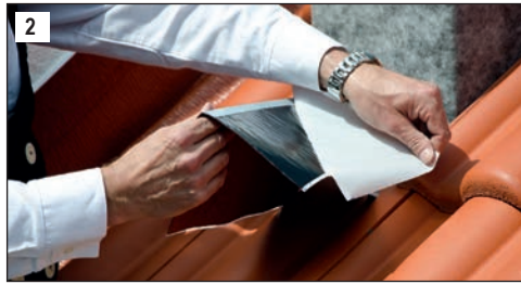
2 Die 2-teilige Schutzfolie kpl. abziehen. CASA-Flash auf einer Seite fixieren. Das lose Ende vom Eindeckmaterial anheben und CASA-Flash mit der Hand in Richtung loses Ende flächig und ohne Zug anformen.
