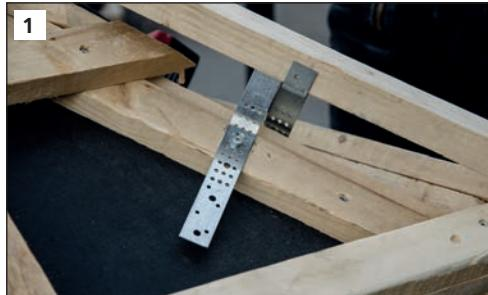
**DE** Firstlatte an Halter befestigen und Dachziegel von losem Staub und Schmutz befreien.
