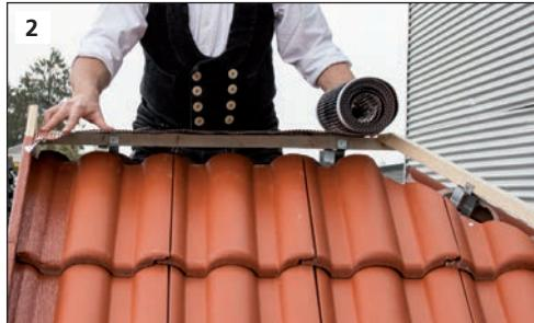
**DE** CASA-Alu ausrollen, Eigenzentrierung durch Form der Rolle gewährleistet.
